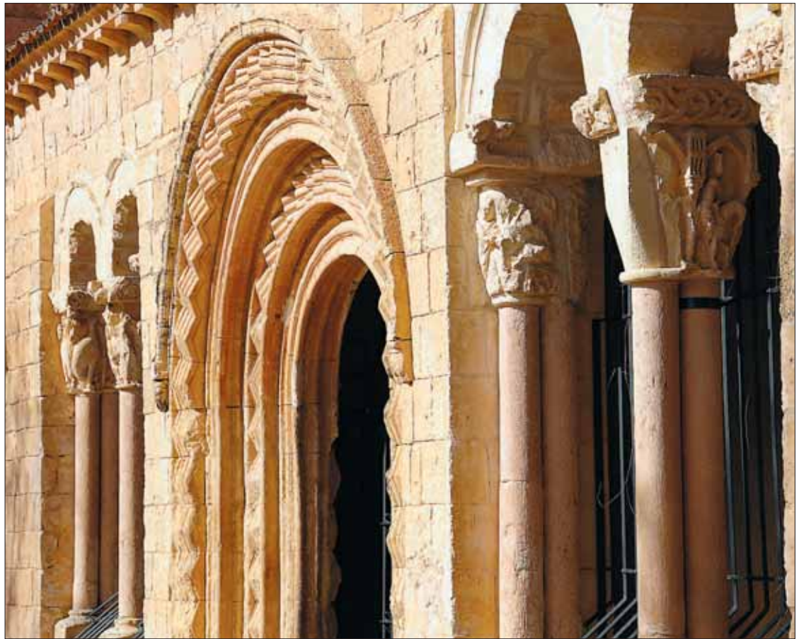
Puerta de acceso al templo de San Pedro de Gaillos cuyo pórtico está formado por un arco de medio punto con dovelas con decoración geométrica.
